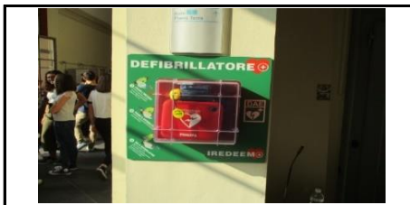
ATRIO D'INGRESSO IN CORRISPONDENZA DELLA POSTAZIONE DEI COLLABORATORI SCOLASTICI
